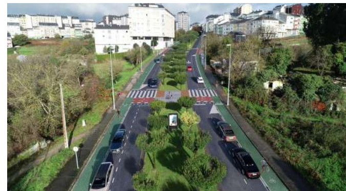
Exemplo de actuación na que se sustitúe un carril de circulación por unha vía ciclista separada
