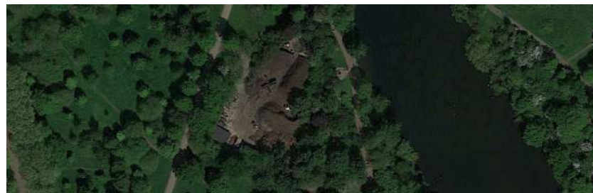
Kensington Gardens, Londres Planta integrada en parque histórico para o tratamento de refugallo verde
