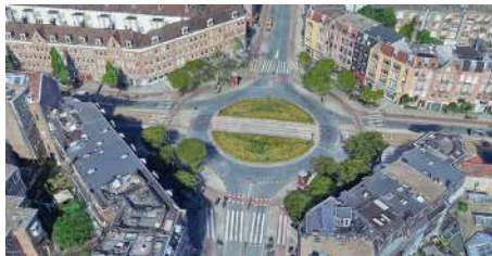
Vías ciclistas a nivel en rotonda (Amsterdam, Países Bajos) (Google)
