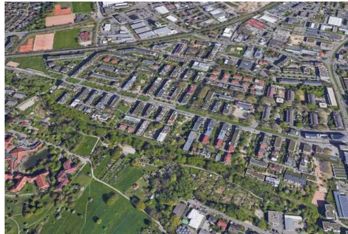
Comunidade sen coches en Vauban (Google)
