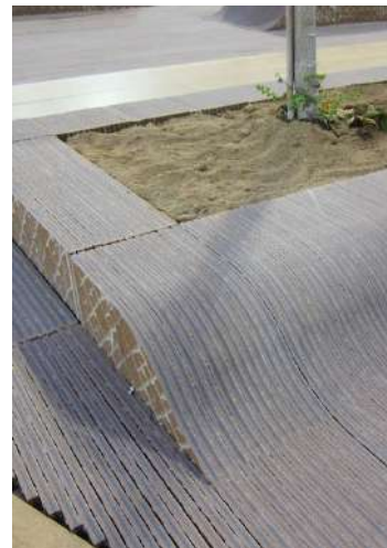
Pavimento reciclado do proxecto LIFE CERSUDS
