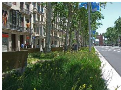
Remodelación do Passeig de Sant Joan, Barcelona Lola Domènech Arquitecta
