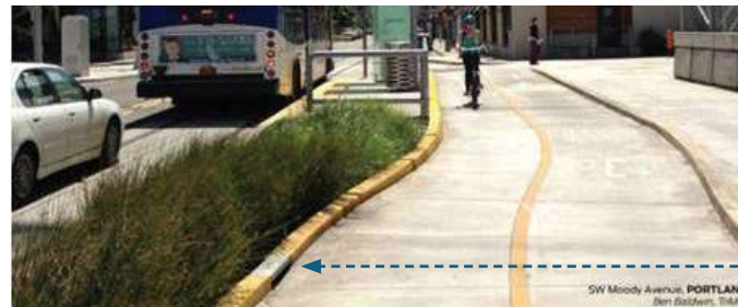
Esquema e exemplo de bordo intermitente. As pluviais de zonas impermeábeis recóllense en áreas de biorretención Fonte: Urban Street Stormwater Guide. National Association of City Transportation Officials.
